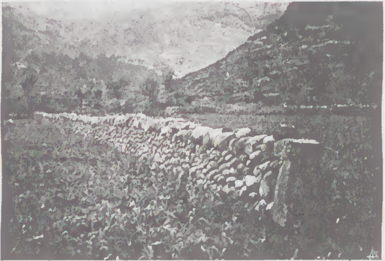
Muro construído com jogas do rio
