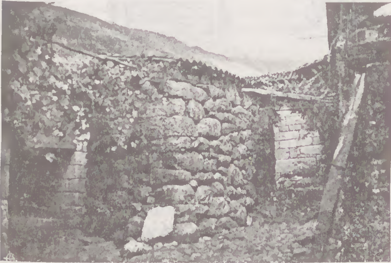
Casa de forma bizarra. Necessidade de aproveitar o espaço entre caminhos. Reparar nos calhaus rolados da construção
