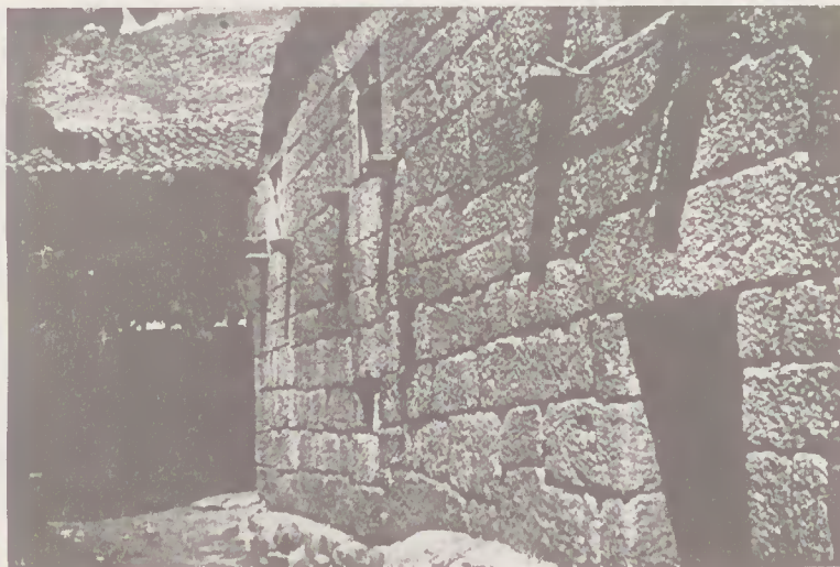
Casa de alvenaria com cachorros aos lados das janelas
